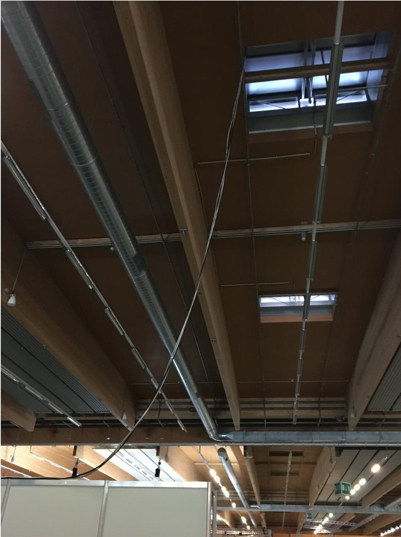
Durch eine Dachluke konnte dann der Kabelstrang ins „Shack“ verlegt werden. Insgesamt sind etwa 100m Koaxial- und Satkabel zum Einsatz gekommen. Als Betriebsarten wurden umgesetzt: QO-100 SSB (TX+RX), QO-100 DATV (RX), SSB auf Kurzwelle (TX+RX) mit einem Dipol.
