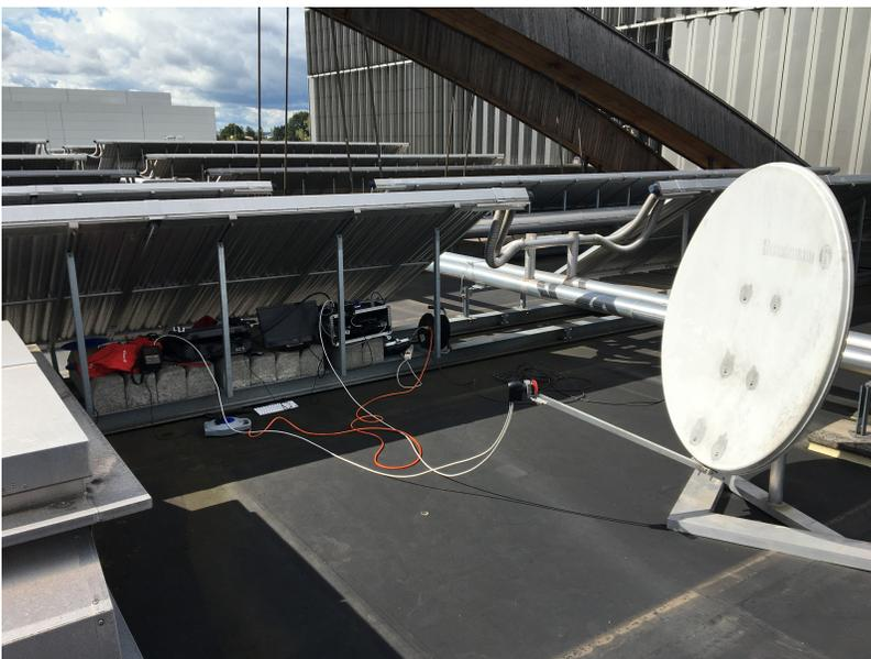
Um eine Beschädigung des empfindlichen Foliendaches zu vermeiden, war ein eigens dafür vorgesehener Spiegel Standfuß aus Aluminium angefertigt worden. Für den Probetrieb musste die gesamte Station am Dach aufgebaut werden. Zusätzlich hatte der Wettergott seine Einwände und schickte als Protestnote einige ergiebige Regenschauer. Zum Glück war eine Solaranlage montiert, die etwas Schutz geboten hat. Bekanntlich reagiert Elektronik allergisch auf Feuchtigkeit.
